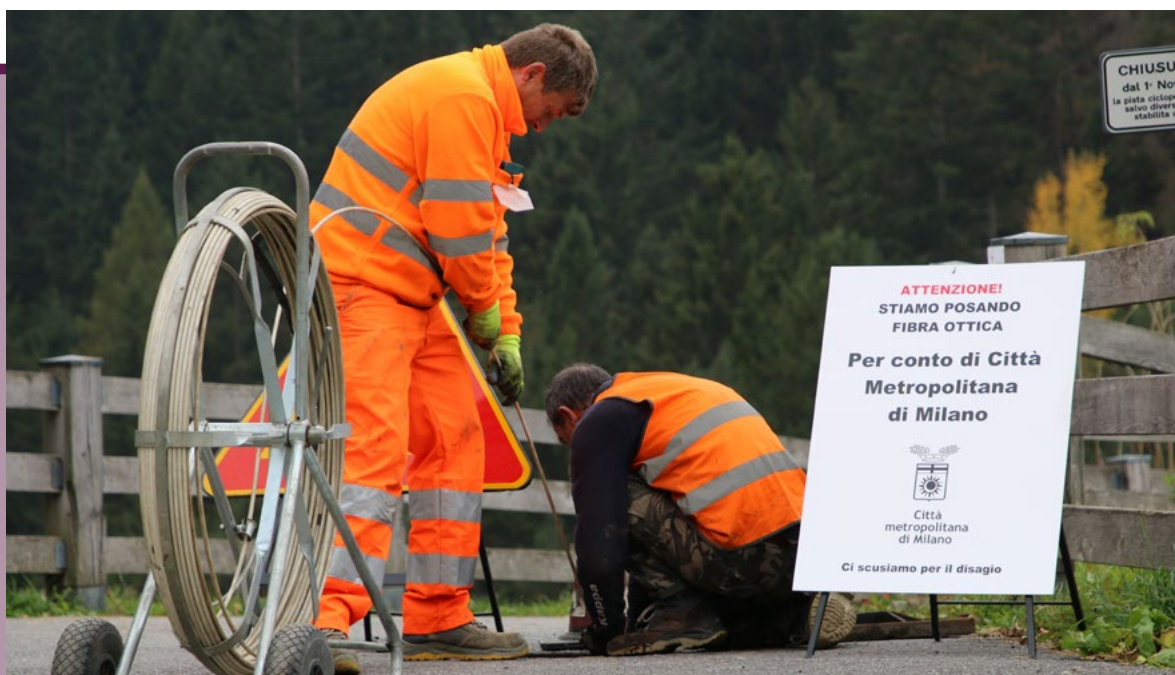
Cantiere fibra ottica
